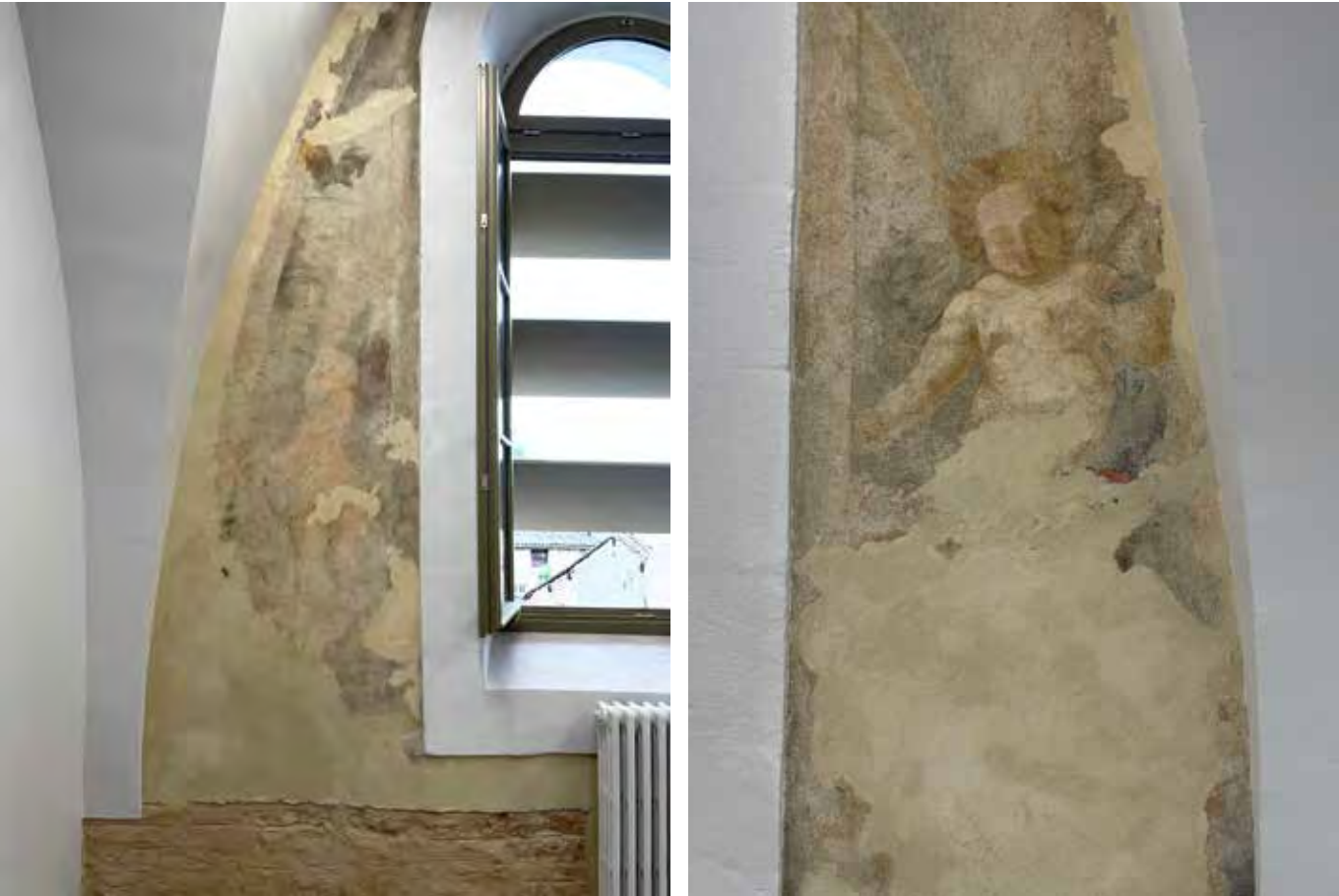
Parois Sud du niveau 1, de l'Ouest à l'Est baies 1 et 2
