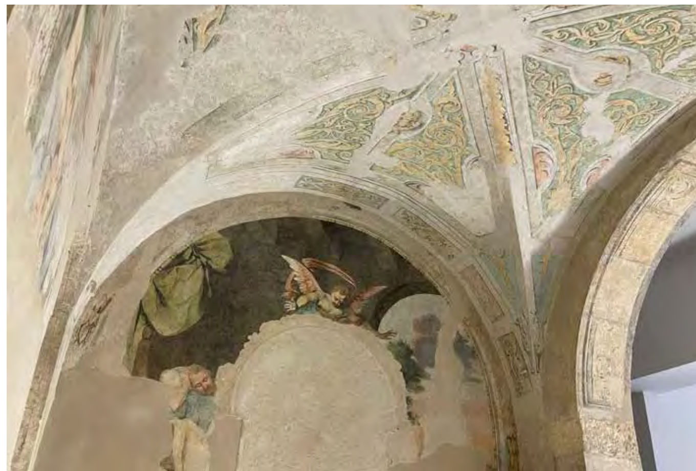
La chapelle, après restauration, février 2023.
