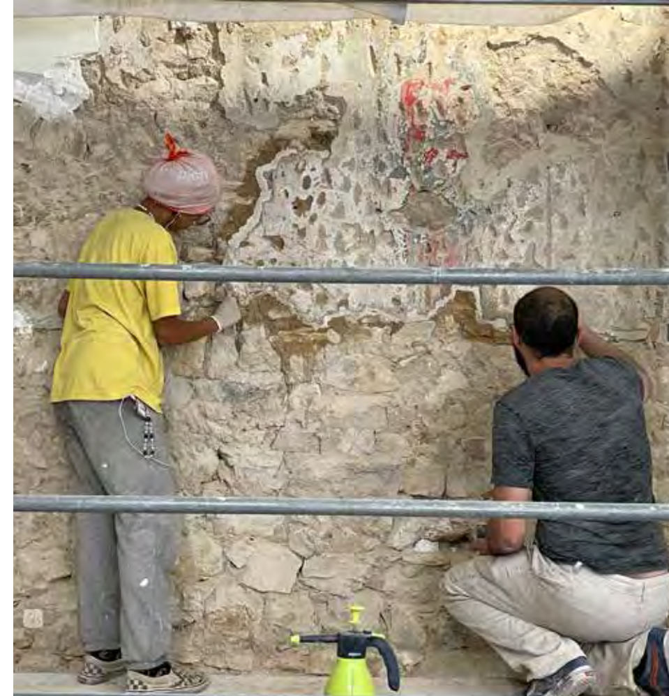
Dégagement mécanique de la paroi Sud du rez-de-chaussée, avec la pose simultanée de solins avant le retrait complet des bouchages profonds de plâtre, juillet 2022.
