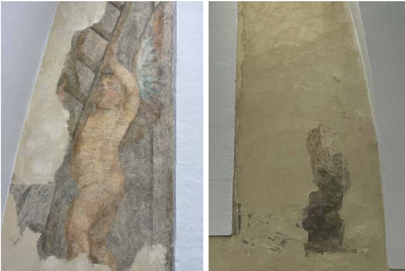
Parois Nord du niveau 1, baies 1 et 2
