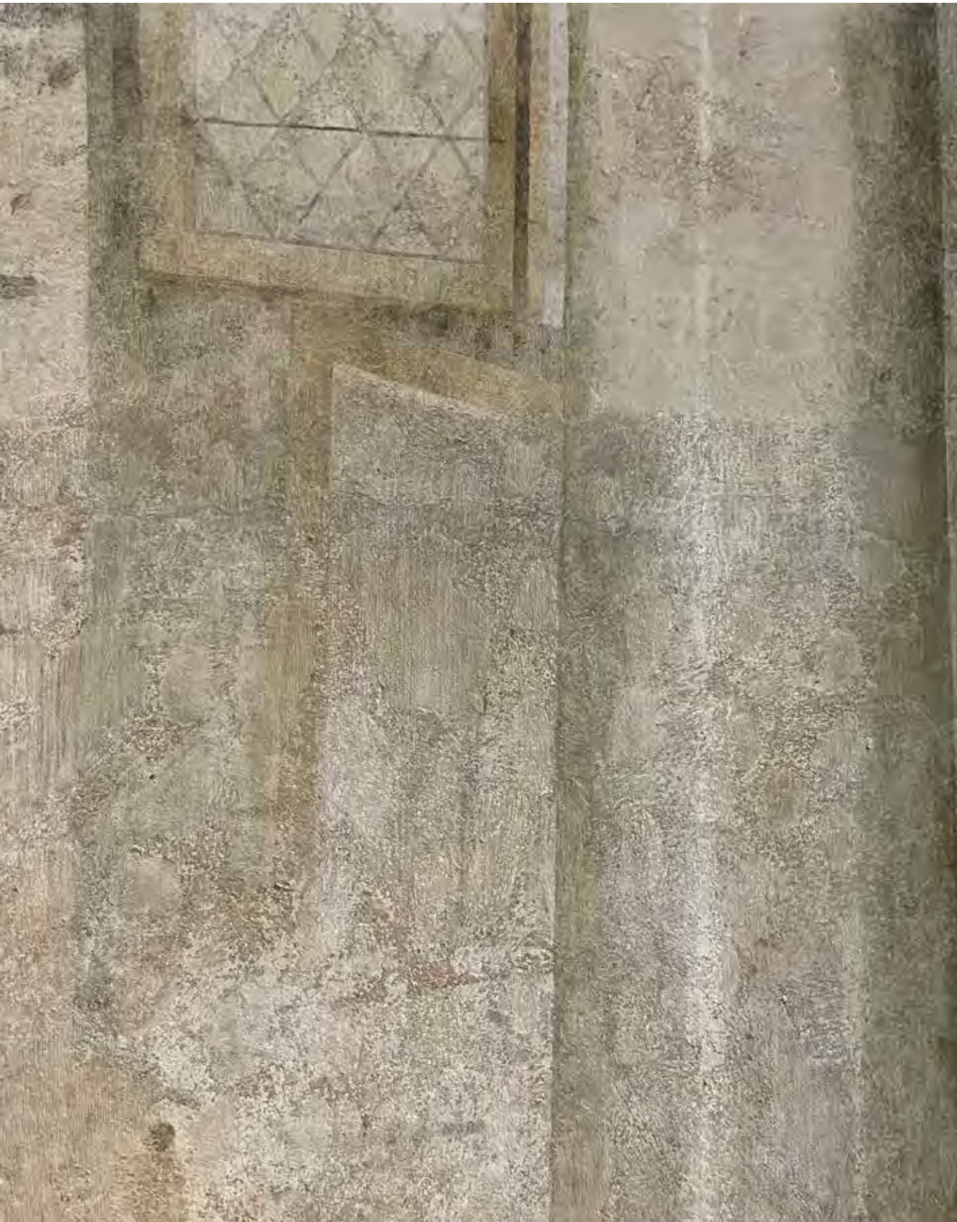
Paroi Sud côté Est, détail d'une colonne et d'une fenêtre à meneaux ou guichet. Les verres en losange sont mis en plomb donnant des motifs de croisillons.
