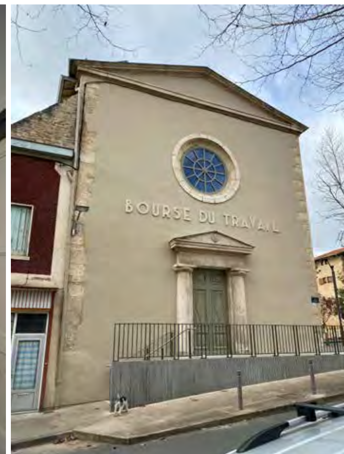
Façade Est, après rénovation du bâtiment par RAS architectes, février 2022.
