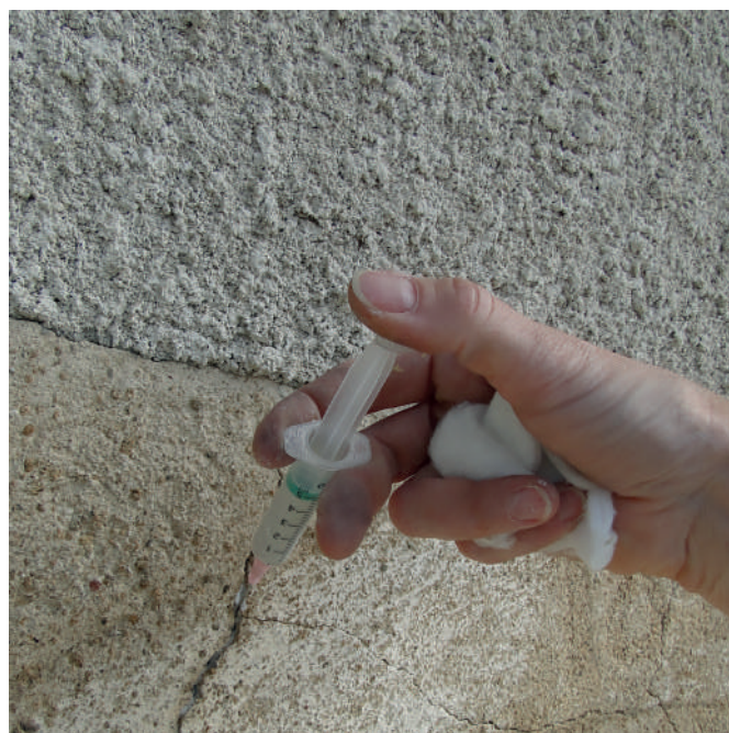
Injections dans les fissures Juin 2021
