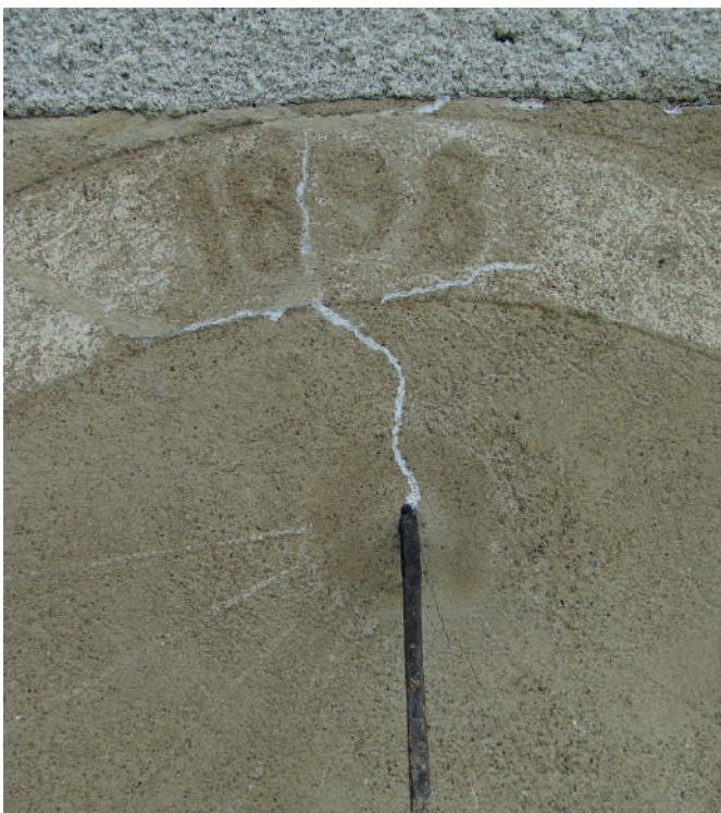
Bouchages des fissures, Juin 2021
