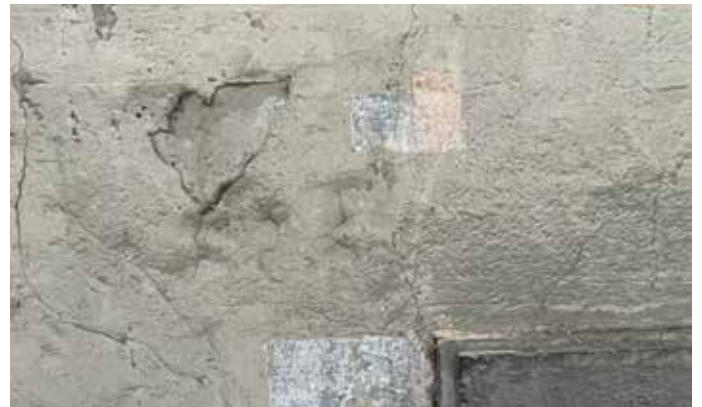
Fenêtres de sondage façade Est et façade Sud
