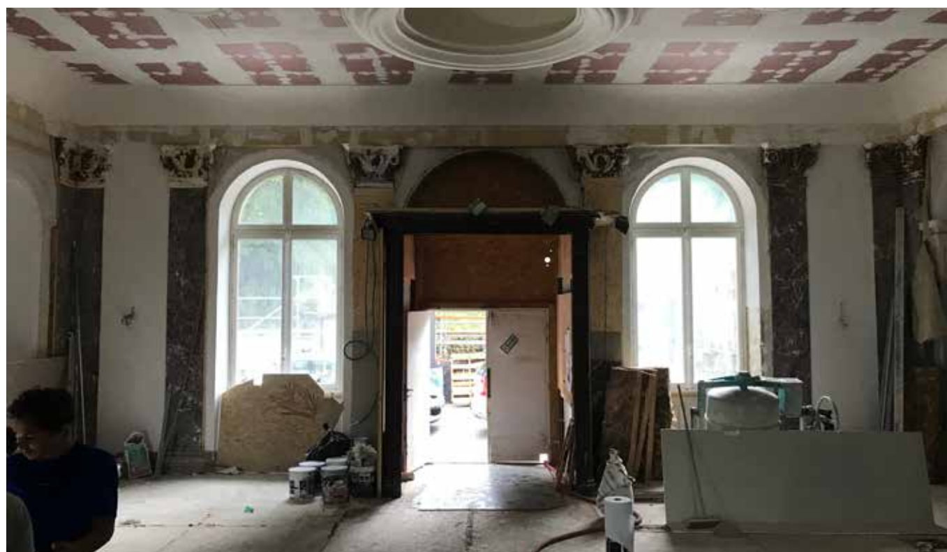
Ancien hôtel Le Bernascon, quatre vues des parois du hall d'entrée en août 2021.
