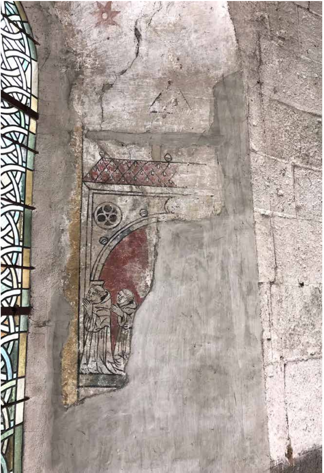
Détail de l'ébrasement sud de la baie.
