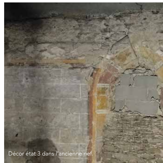
Décor état 3 dans l'ancienne nef.
