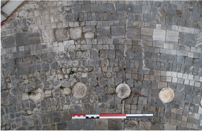
Altération des tesselles dans la masse : vue générale et détail
