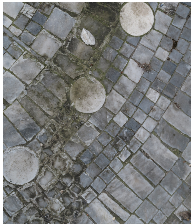
Altération dans la masse des tesselles : érosion de surface et altération de type lamellaire
