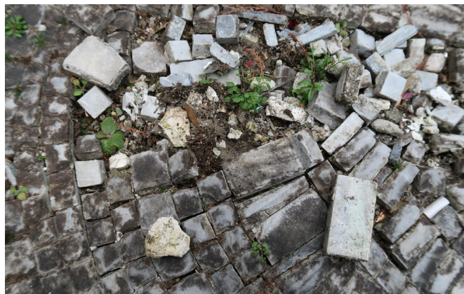
Lacune réintégrée dont les tesselles se détachent, échantillon du mortier de pose blanc
