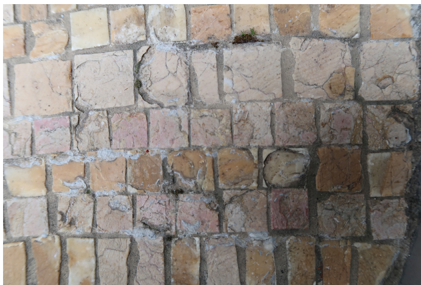
Altération dans la masse des tesselles : érosion de surface et altération de type lamellaire
