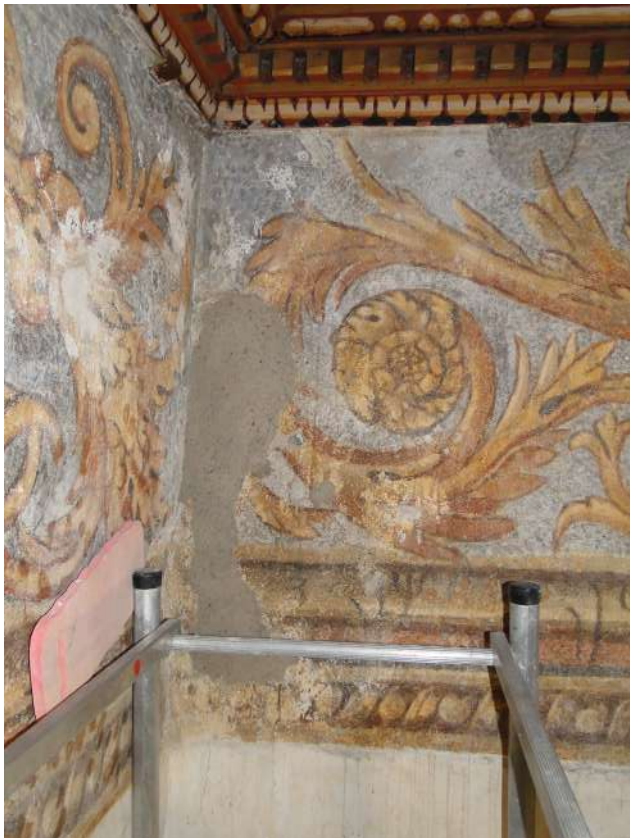
Angle Nord/Est, au dessus de la mezzanine, avant traitement. Pose de solins. Reprise de l'enduit. Après retouche.
