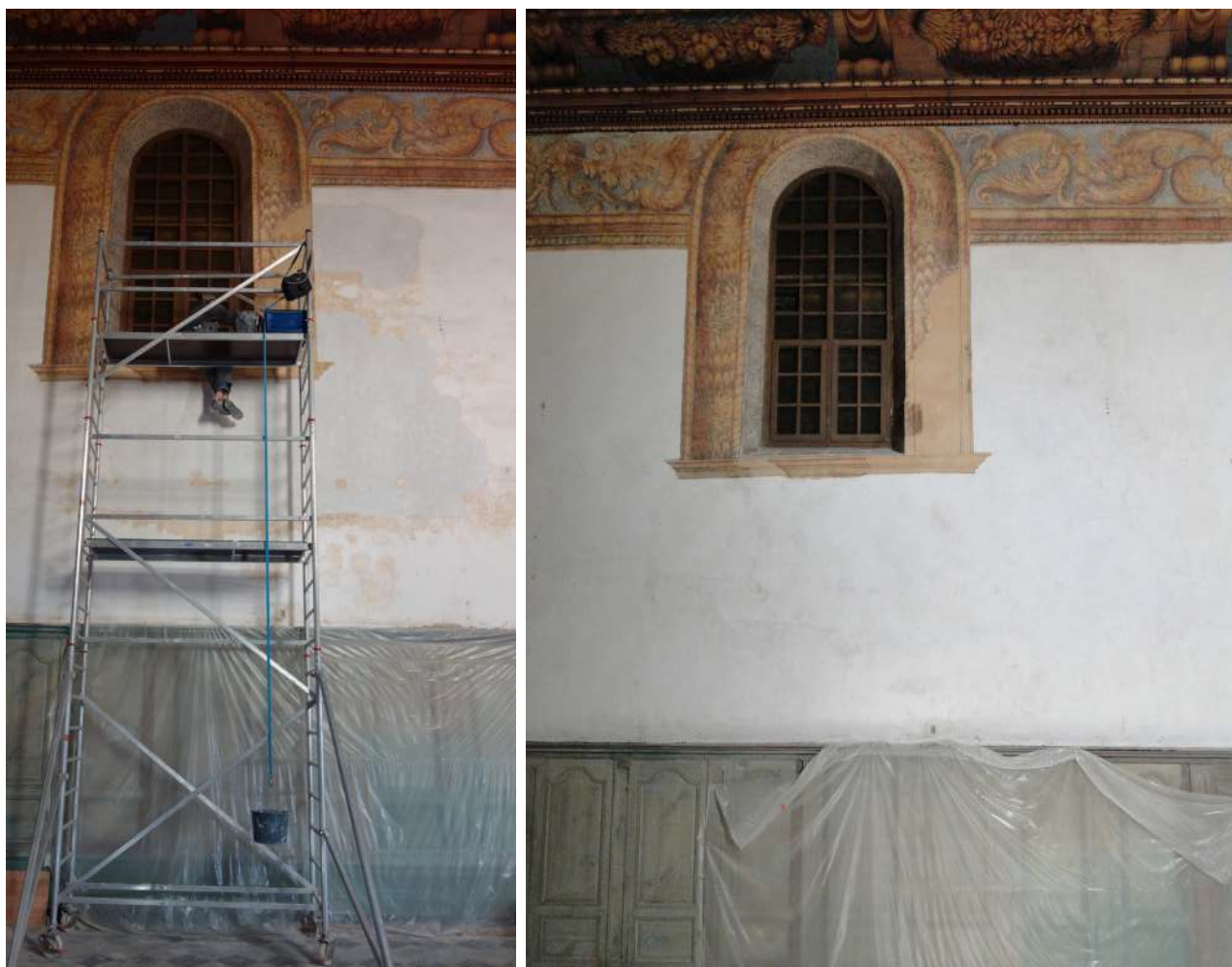
Une patine a été posée sur la lacune pour l'intégrer à la paroi.
