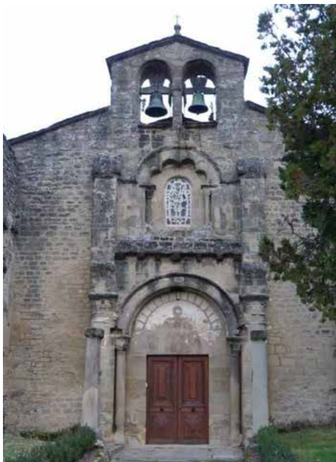
Façade du prieuré Sainte-Agnès, Avant travaux en 2010 Après réintégration des enduits août 2020 Après retouche finale en Septembre 2020.
