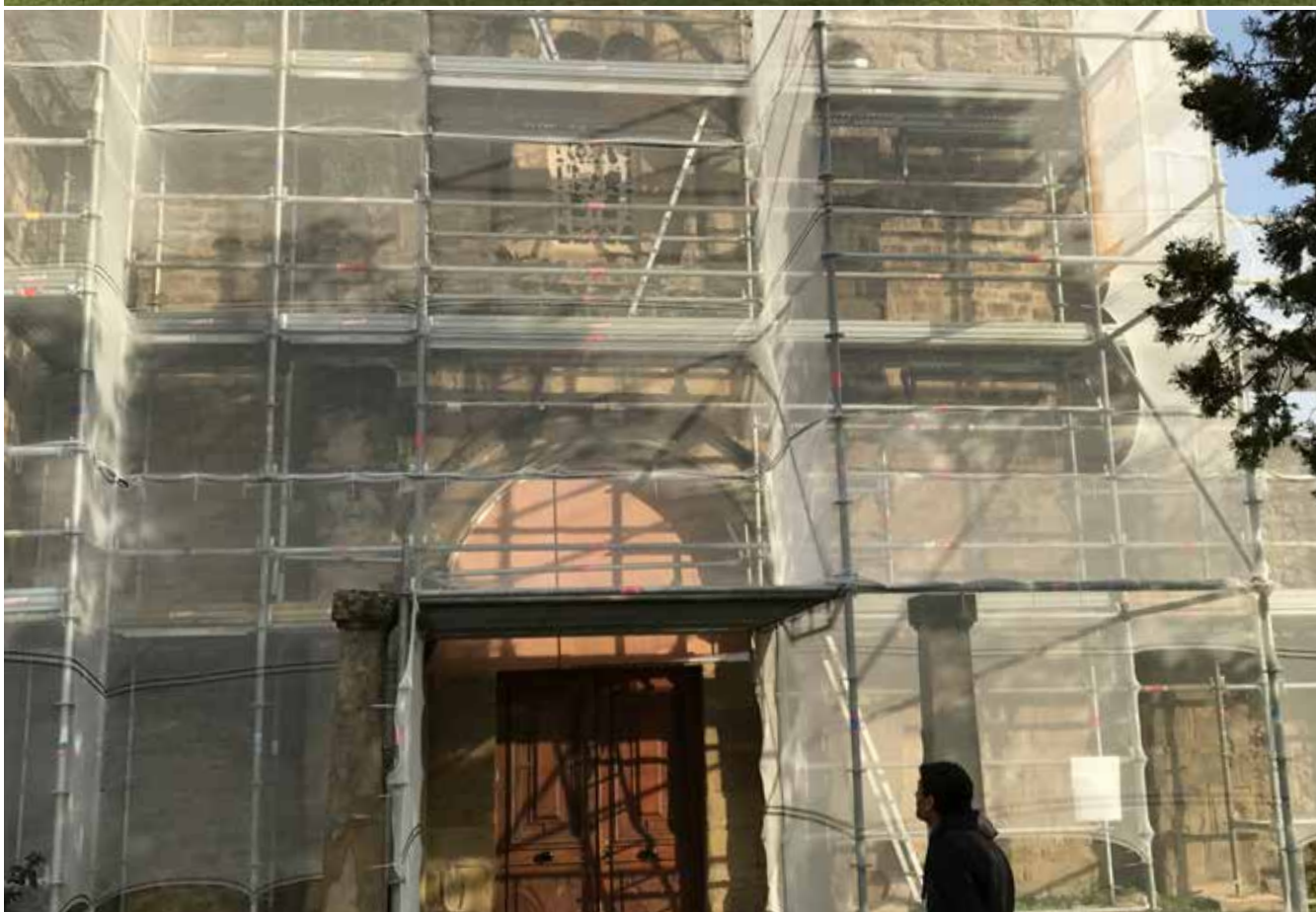
Façade du prieuré Sainte-Agnès, La Motte-de-Galaure, en cours de travaux, Décembre 2019.
