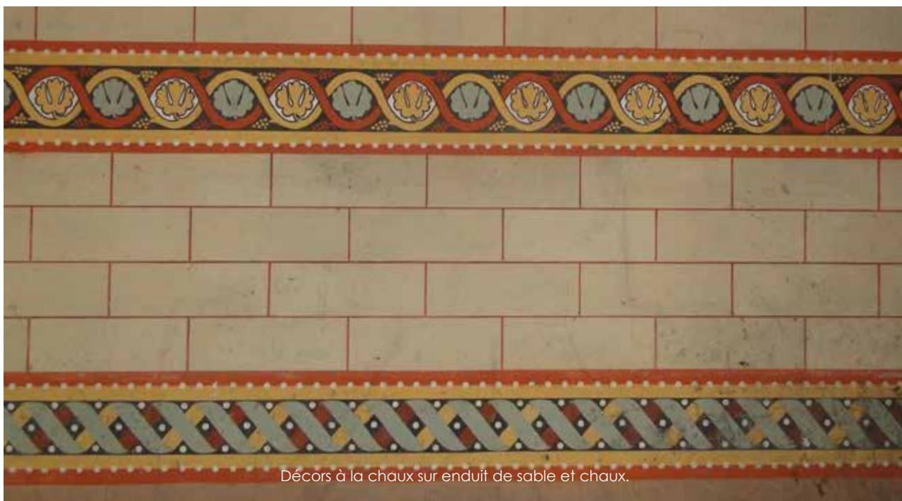
Pierre de tuf et ses joints rouges.
