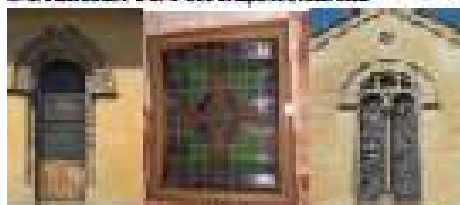
État des vestiges en façade occidentale (est et transept), après démolition d'une des chapelles latérales
